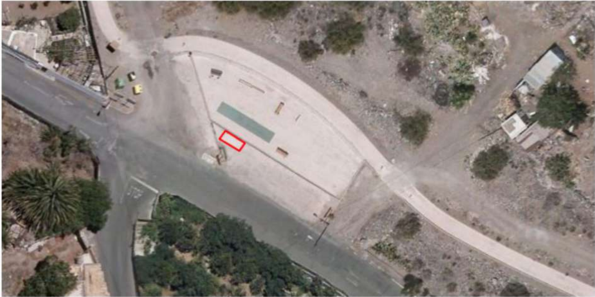
Localización en C/ Molino de Agua
